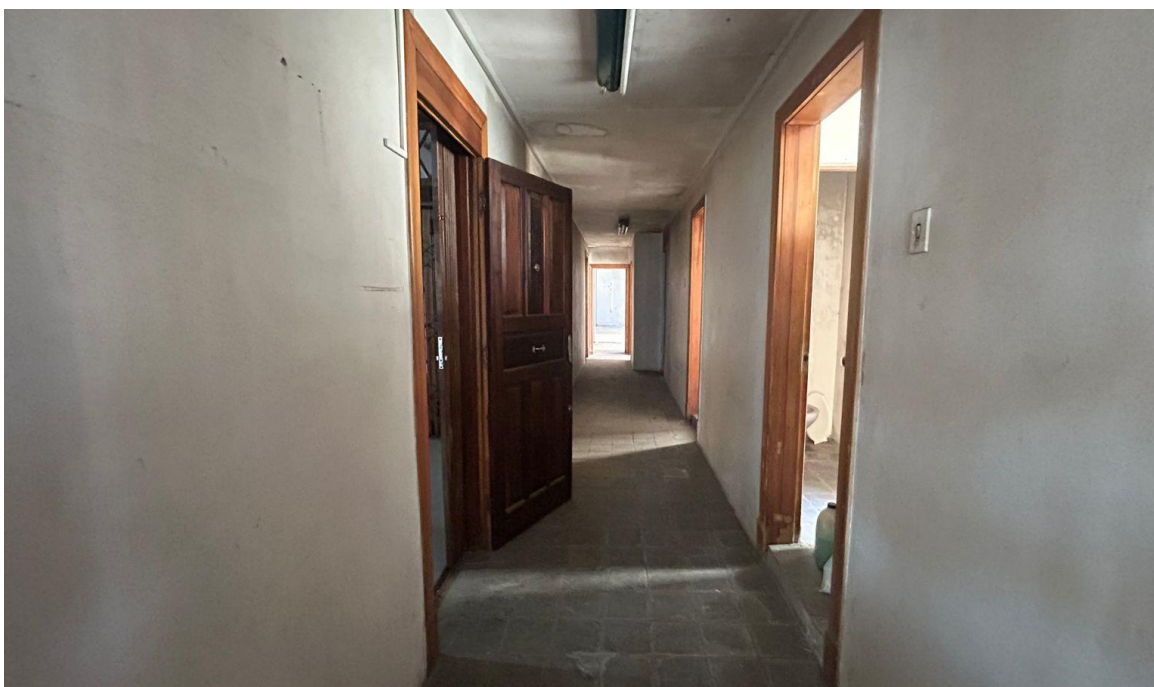
Foto 16: Corredor interno Fonte: Carvalho Lira Engenharia, 2026
