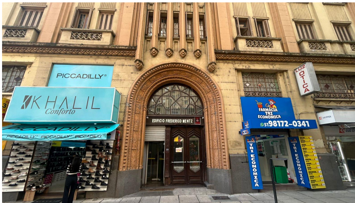
Foto 1: Fachada frontal do imóvel Fonte: Carvalho Lira Engenharia, 2026
