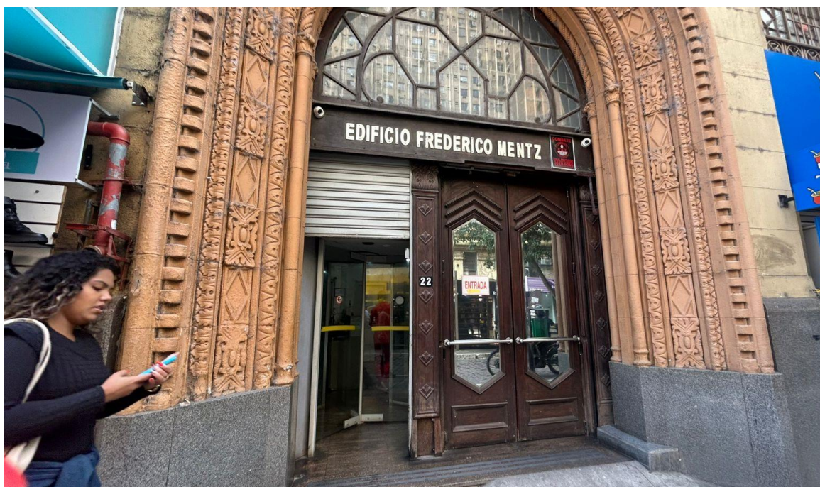
Foto 2: Entrada Fonte: Carvalho Lira Engenharia, 2026
